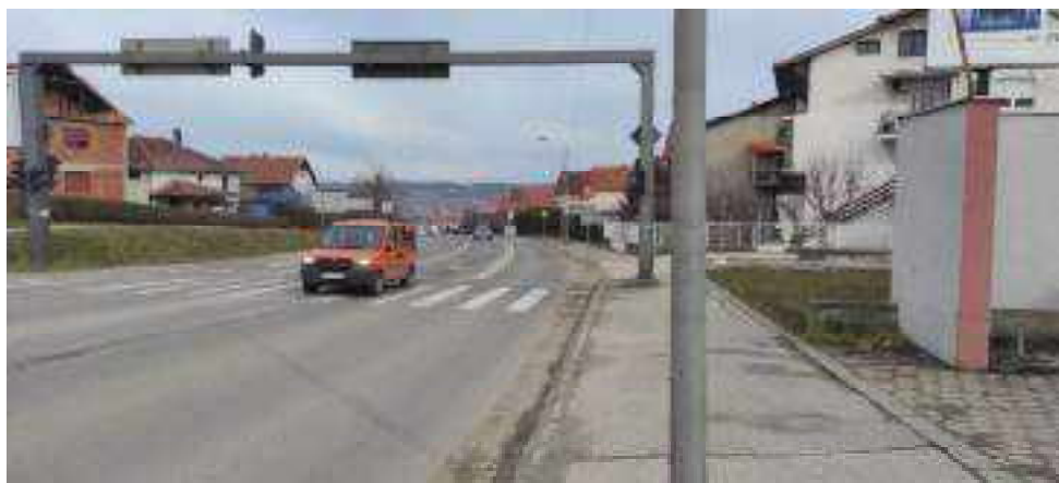
Slika 2.: Fotografija predmetne saobraćajnice (krak 1)
